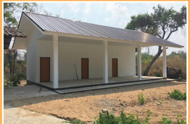
โครงการก่อสร้างศาลาป่าช้าบ้านปวงสนุก
